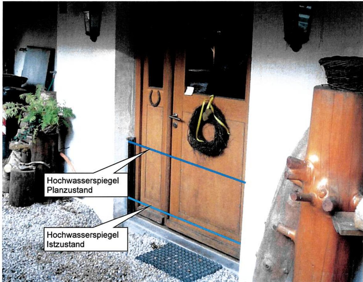
Abbildung 4.9: Hochwassersituation an der Kellertür Haus Nr. 12
